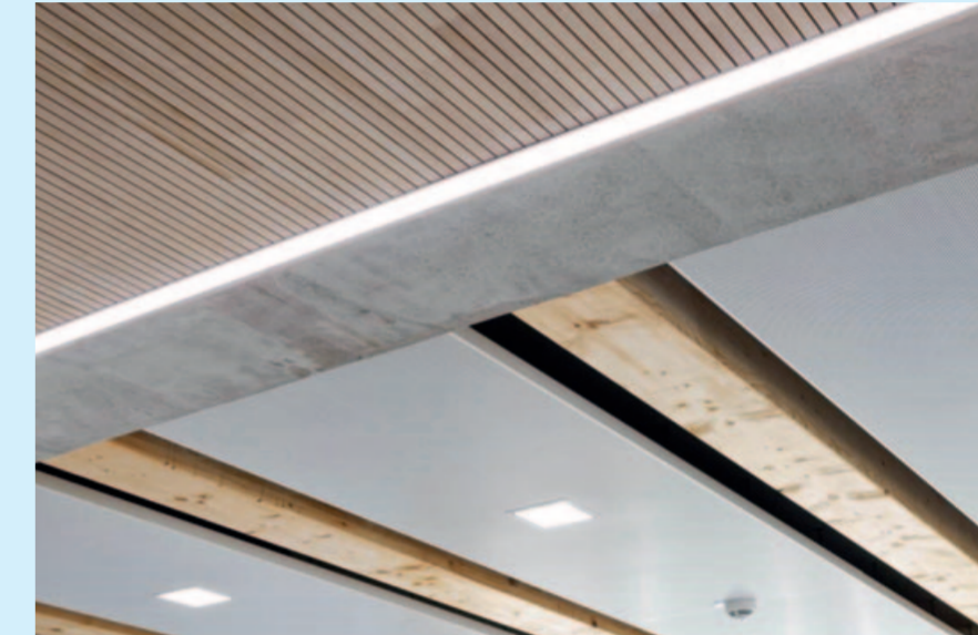
Verbunddecken aus Holzbeton wirken sich positiv auf die Biodiversität aus, verfügen über eine niedrige CO 2 -Bilanz, sind langlebig und recycelbar
