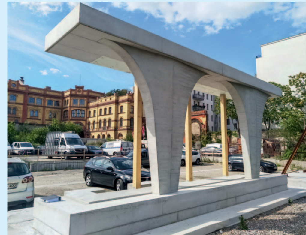
Prototyp für eine Stützenkonstruktion aus Recycling-Beton
