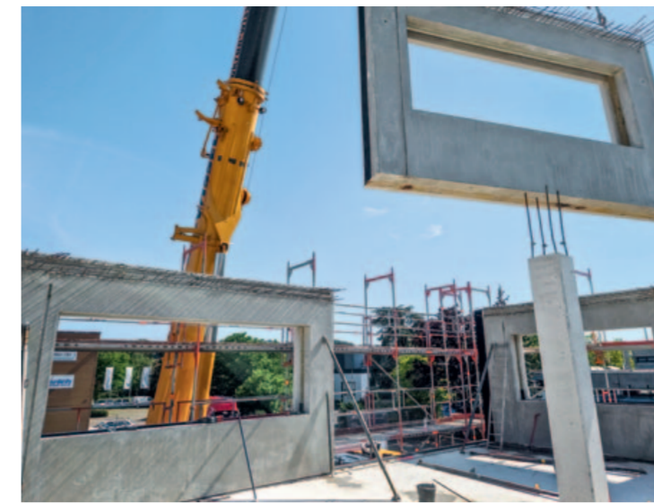
Montage der Fertigteilelemente
