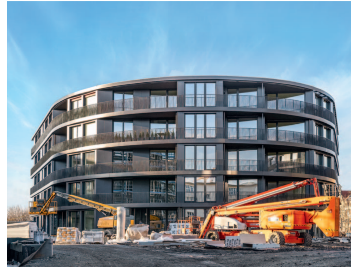
Der geschwungene Baukörper mit den umlaufenden Geländern nimmt Formen an
