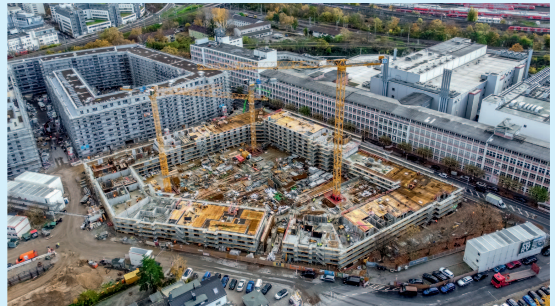
Unkonventionell und wegweisend: Das Wohnquartier FRANKY, das Dreßler Bau in Frankfurt realisiert, verfügt über ein innovatives Energiekonzept. Das Viertel wird nämlich durch die Abwärme des benachbarten Rechenzentrums beheizt. 60 % des Wärmebedarfs können dadurch abgedeckt werden.
