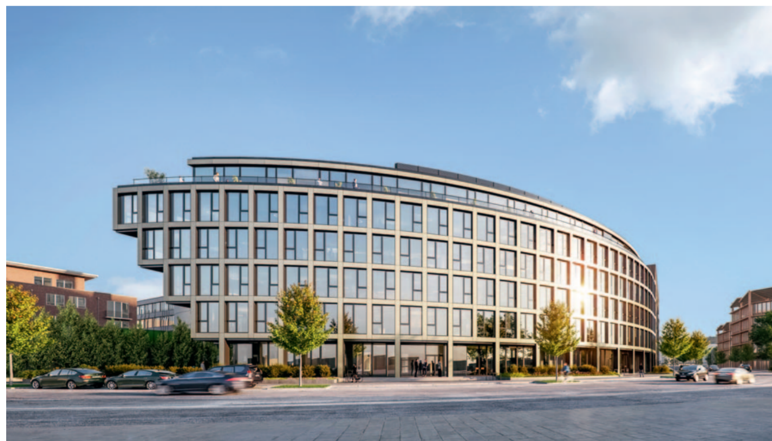
Ab nächsten Sommer wird die Photovoltaik-Glas-Fassade in vollem Glanz erstrahlen
